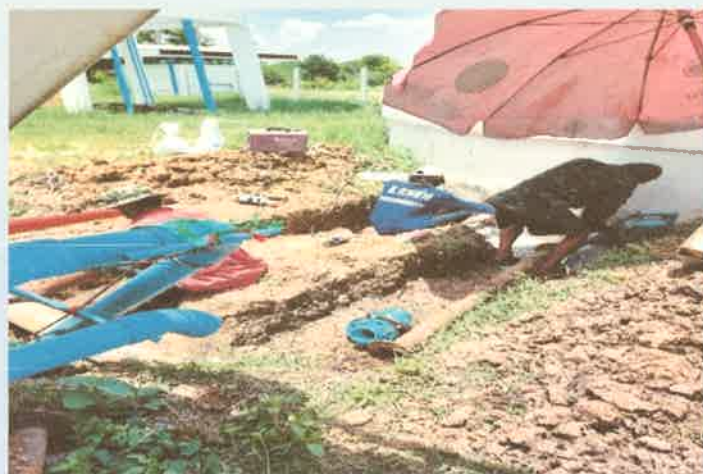
การซ่อมท่อทางดูดและท่อทางส่งของเครื่องสูบน้ำแรงสูง บริเวณสถานที่ผลิตน้ำประปาแห่งที่ ๓ (สระน้ำวัดบ้านวัด)
