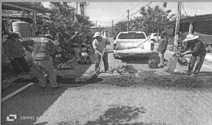
ซ่อมแซมถนนเทศบาล 1 และ เทศบาล 8 จัดทำลูกระนาดเพื่อชะลอความเร็ว ป้องกันอุบัติเหตุในหมู่บ้านและชุมชน
