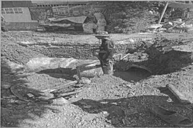
- งานซ่อมแซมและบำรุงรักษาท่อประปา ถนนเทศบาล 1 หมู่ที่ 9 บ้านวัด
